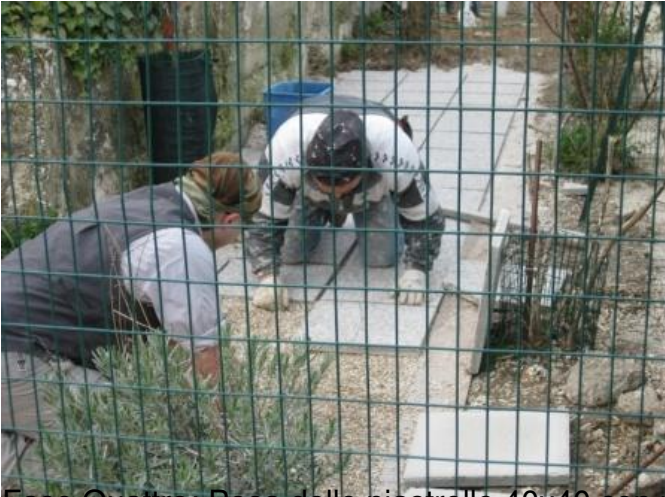
Fase Quattro: Posa delle piastrelle 40x40 con precisione millimetrica
